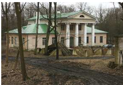
9. att. Bišumuiža pēc remonta 2007. gadā. Foto: J. Smaļinskis, www.videsvestis.lv
